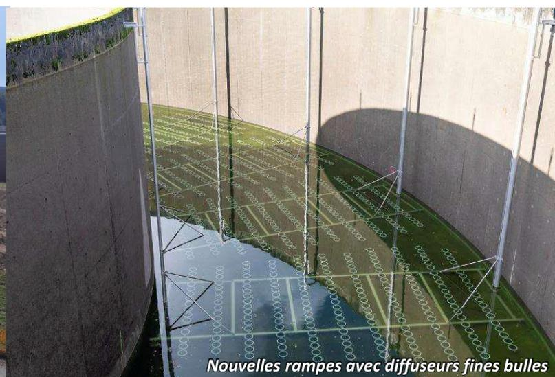
Nouvelles rampes avec diffuseurs fines bulles
