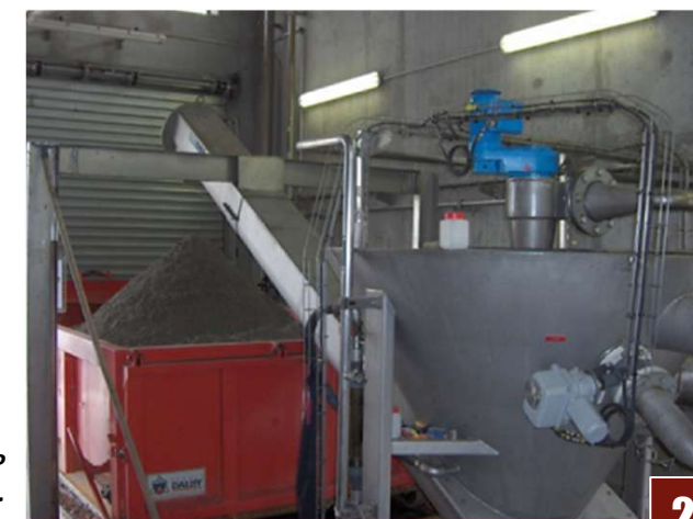
Lavage des sables – STEP principale de Limoges.
