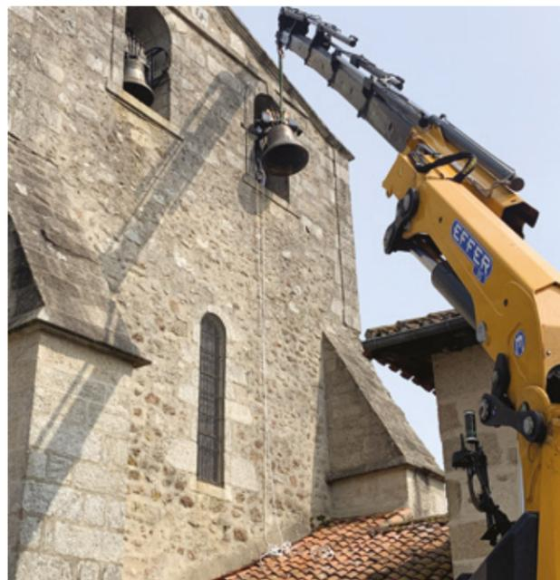
**Désignation** : dépose de la cloche en bronze (250 kg), transport vers les entrepôts d'une entreprise spécialisée, restauration du mécanisme d'accroche et repose de l'équipement campanaire dans le clocher.
