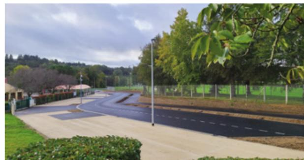
**Désignation** : après les travaux réalisés au cours de l'été (réaménagement de la voirie, création d'une piste cyclable, gestion des eaux pluviales, passage des luminaires en Led...), seuls la végétalisation des espaces verts et le marquage au sol restent à réaliser.
