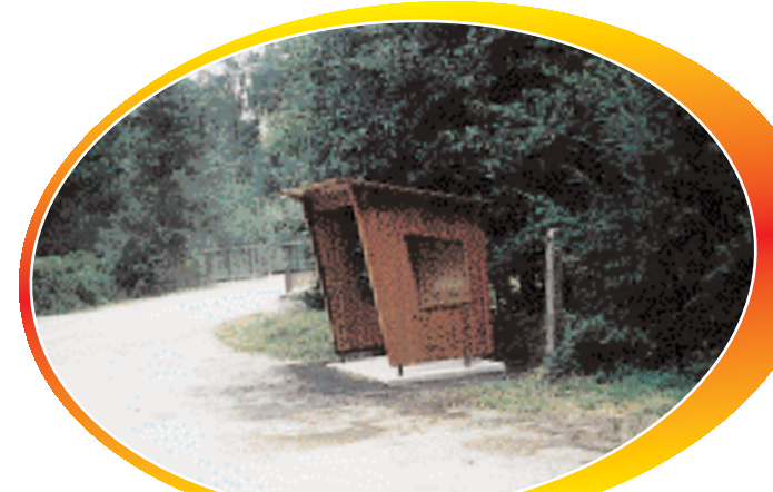
Nouvel abri-bus aux Chabannes.
