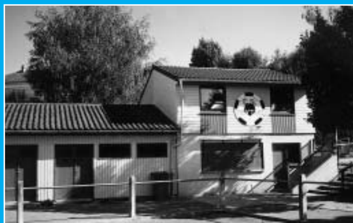
Les peintures extérieures des vestiaires.
