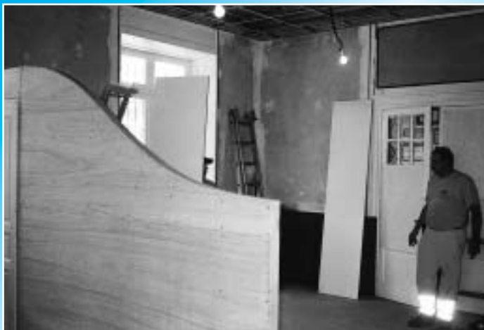
Le bureau d'accueil pendant les travaux...
