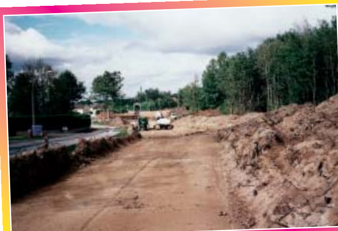
Le chantier de la rue Marcel-Pagnol a commencé.
