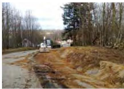
Les agents municipaux exécutent en interne des travaux relatifs à l'élargissement de la rue Marcel Talabot à La Plagne, une acquisition de terrain ayant été effectué pour rendre ce chantier réalisable. Le principe est d'implanter des poutres de rives afin de consolider le bas côté pour le rendre praticable.
