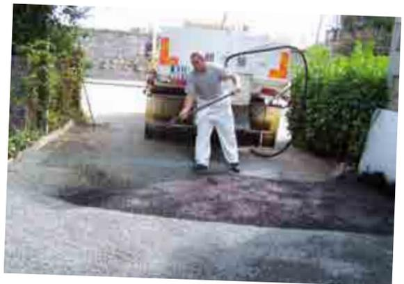
Grâce à un équipement acquis par la commune, nos agents ont pu remettre en état le parking de la maison des associations. Cette technique dite du "point à temps" qui permet de réparer la couche de roulement d'une chaussée qui a subi des dégradations de surface, offre une certaine souplesse d'utilisation.
