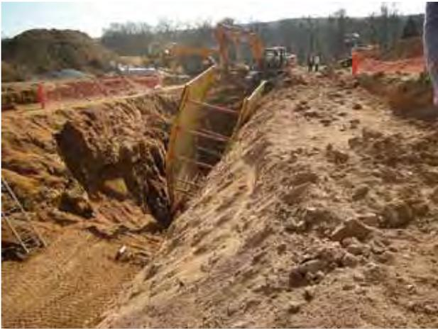
"Des protections draconiennes pour les opérateurs du chantier qui travaillent dans des tranchées frôlant les dix mètres."
