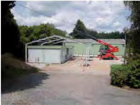
La salle de « grand tilleul » est très appréciée des utilisateurs et devant la dégradation de son état due à la toiture vieillissante, les travaux de rénovation ont commencé avec la réalisation d'une toiture qui conditionnera la réfection des sols abîmés par l'eau. Là aussi c'est la compétence des agents municipaux qui permet le déroulement de ces travaux conséquents en interne.
